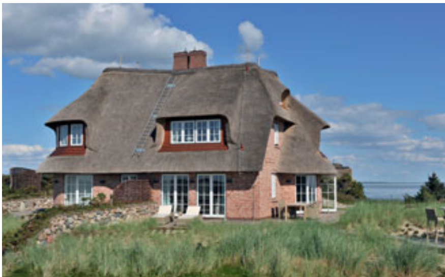
Neubau eines Einfamilienhauses in Rantum
