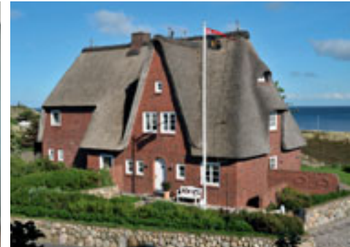
Sanierung eines Doppelhauses in List
